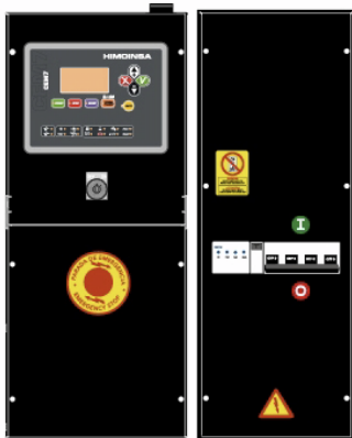
Панель управления ДГУ КОНТРОЛЛЕР СЕМ7
