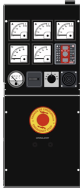
Панель ручного управления ДГУ
